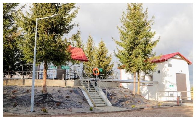
Oczyszczalnia ścieków w Tryńczy
