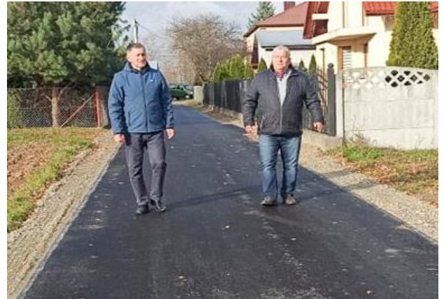
Remont drogi w Gniewczynie Łańcuckiej (boczna DW 835)
