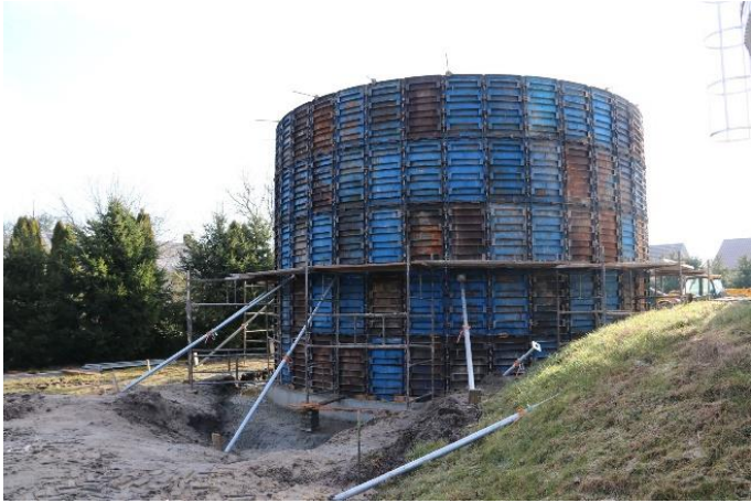
Budowa dodatkowego zbiornika na wodę
