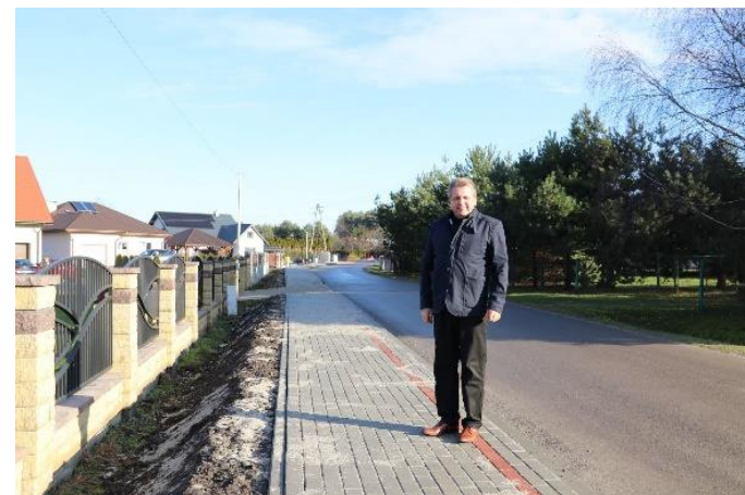
Budowa chodnika w Gorzycach
